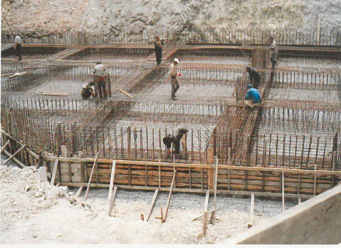
Vakıf binası temeliyle atılan ilk adım
